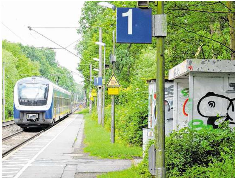
Insgesamt etwa 3,8 Millionen Euro investiert der Bund in die Modernisierung der Bahnhöfe in Schierbrok und Hoykenkamp.
